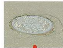
マンホール周り
